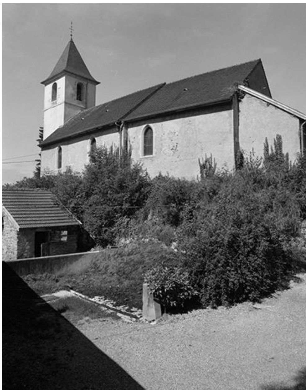
Façade latérale droite.
