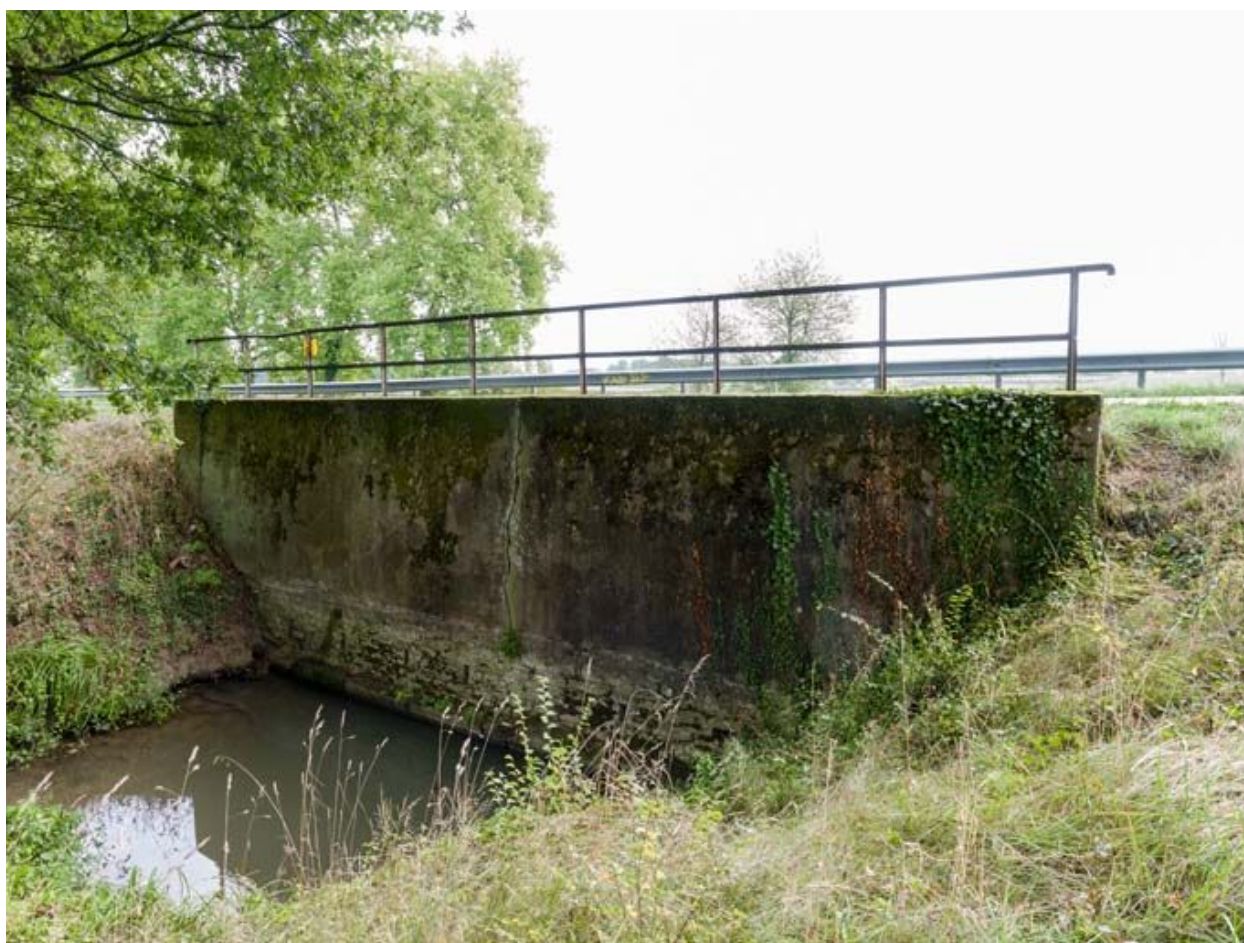
Vue de l'aqueduc.
