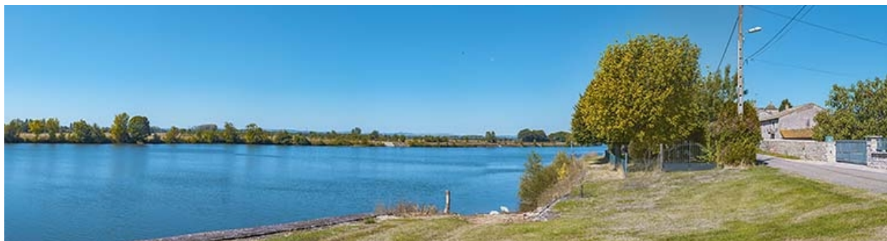
Rampe et perrés au port d'Ouroux.
