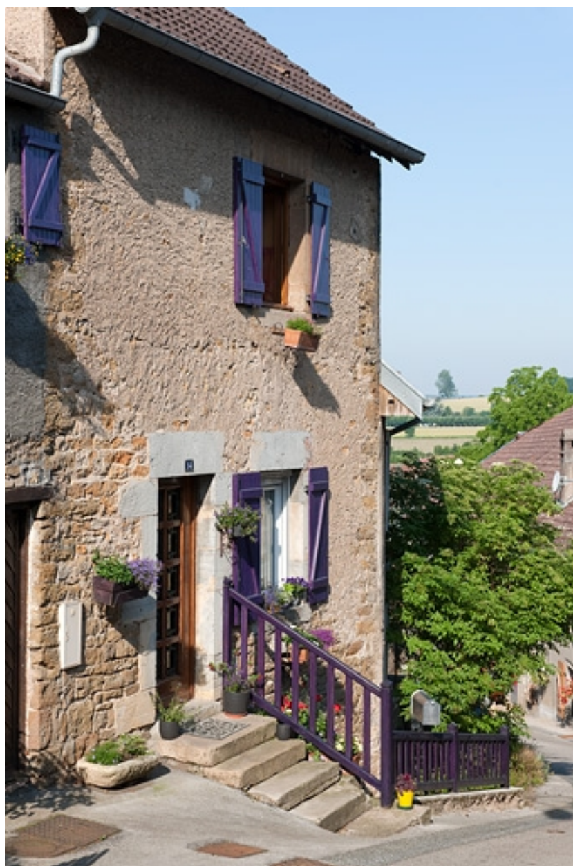
Maison au 14 rue des Gratteris (2010 AK 111).
