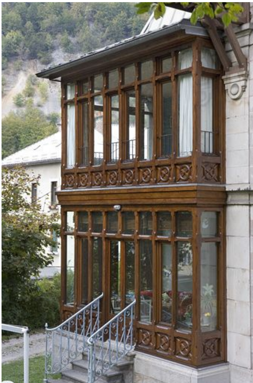
Elévation latérale droite : l'oriel.
