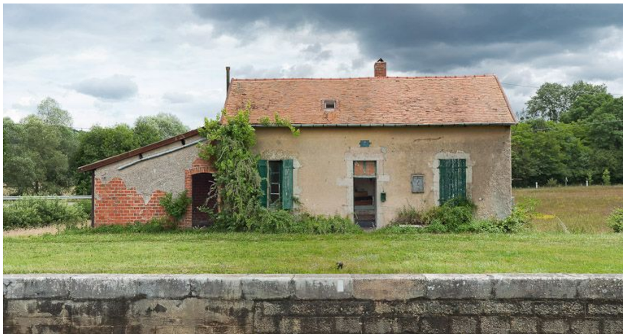
Vue de face de la maison éclusière.
