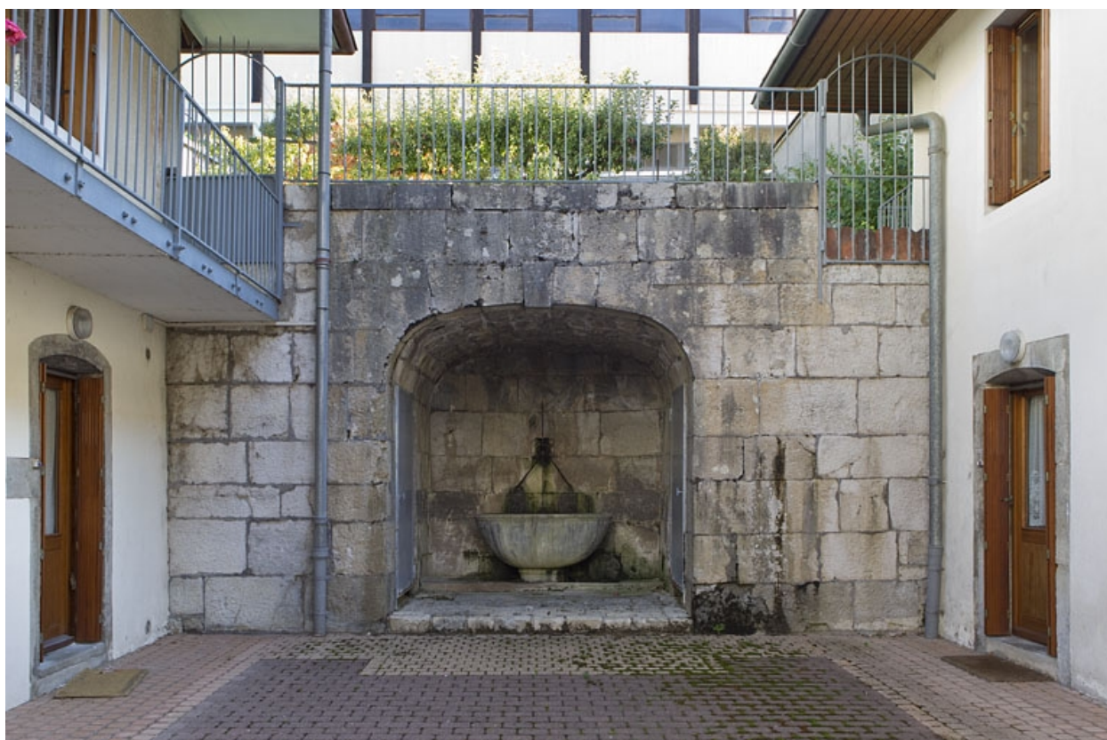
Mur de soutènement, niche et fontaine.
