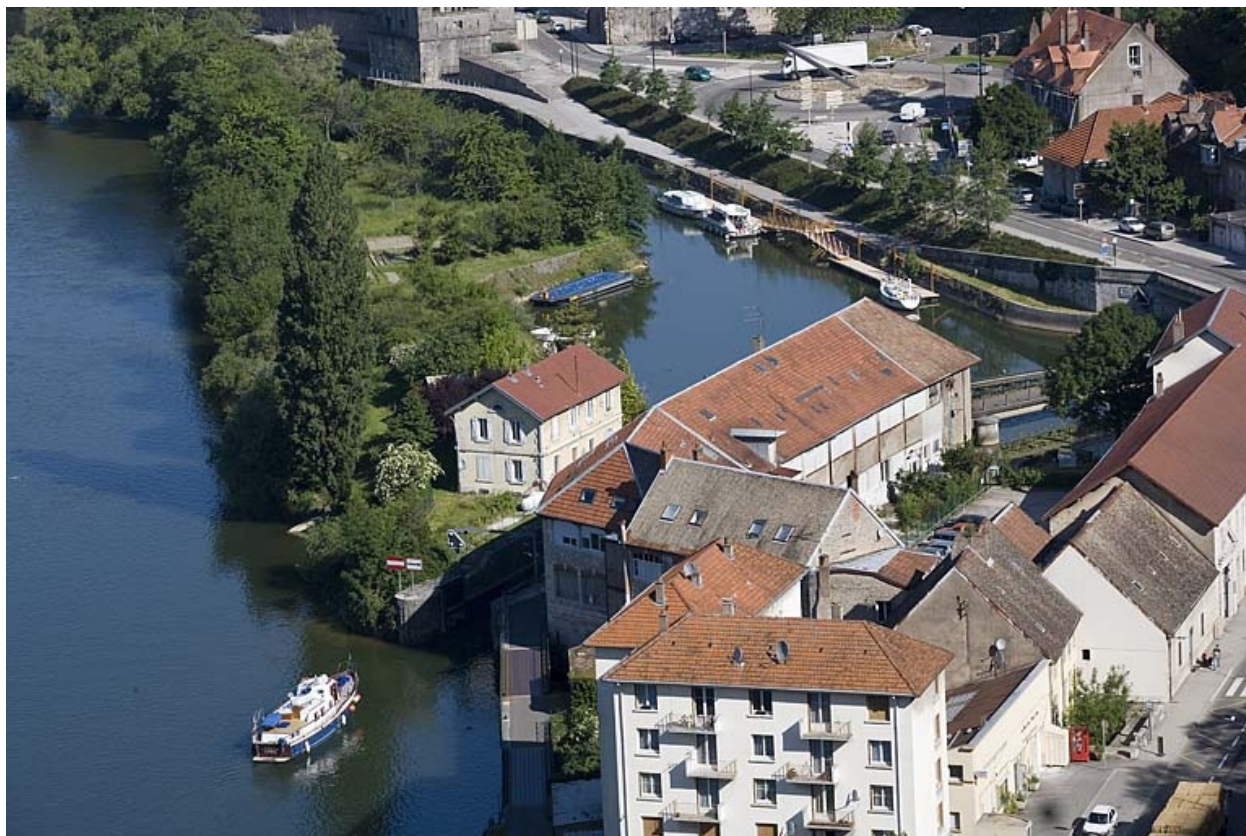
Besançon : écluse n° 51 de Tarragnoz.
