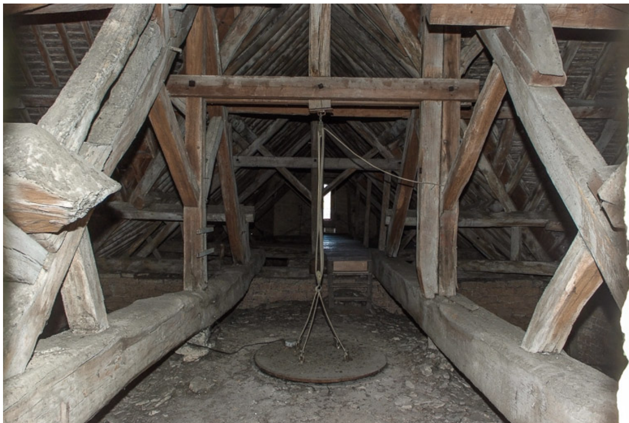
Combles, vue prise au-dessus de la croisée.
