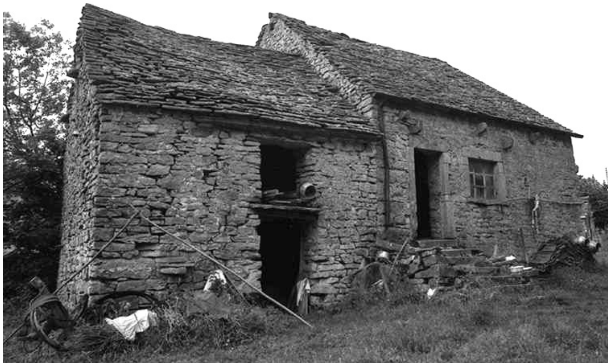
Ferme cadastrée 1960 B 108, située au lieudit La Peyrouse, datée de 1690 : façade antérieure. A noter le toit en lave et les murs pignon en pierre sèche.
