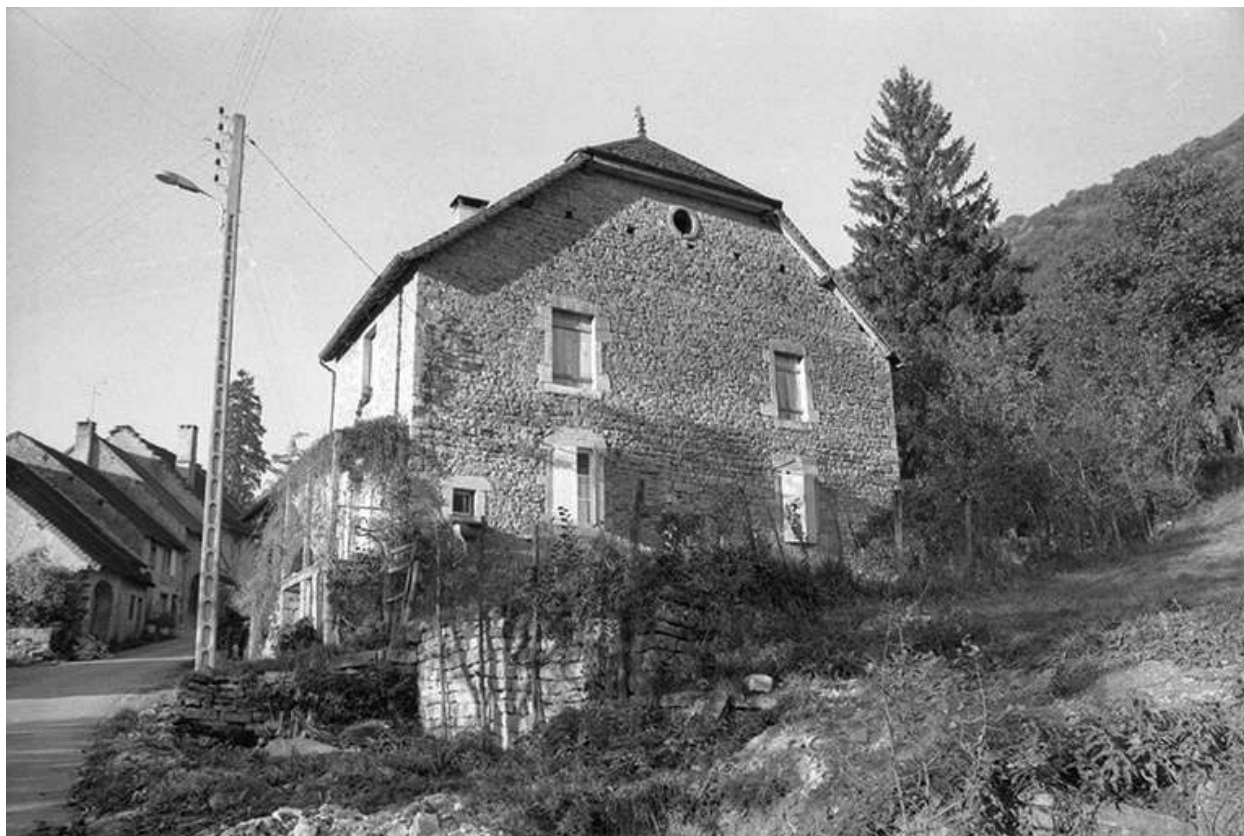
Maison cadastrée 1965 AD 105 : façade est.
