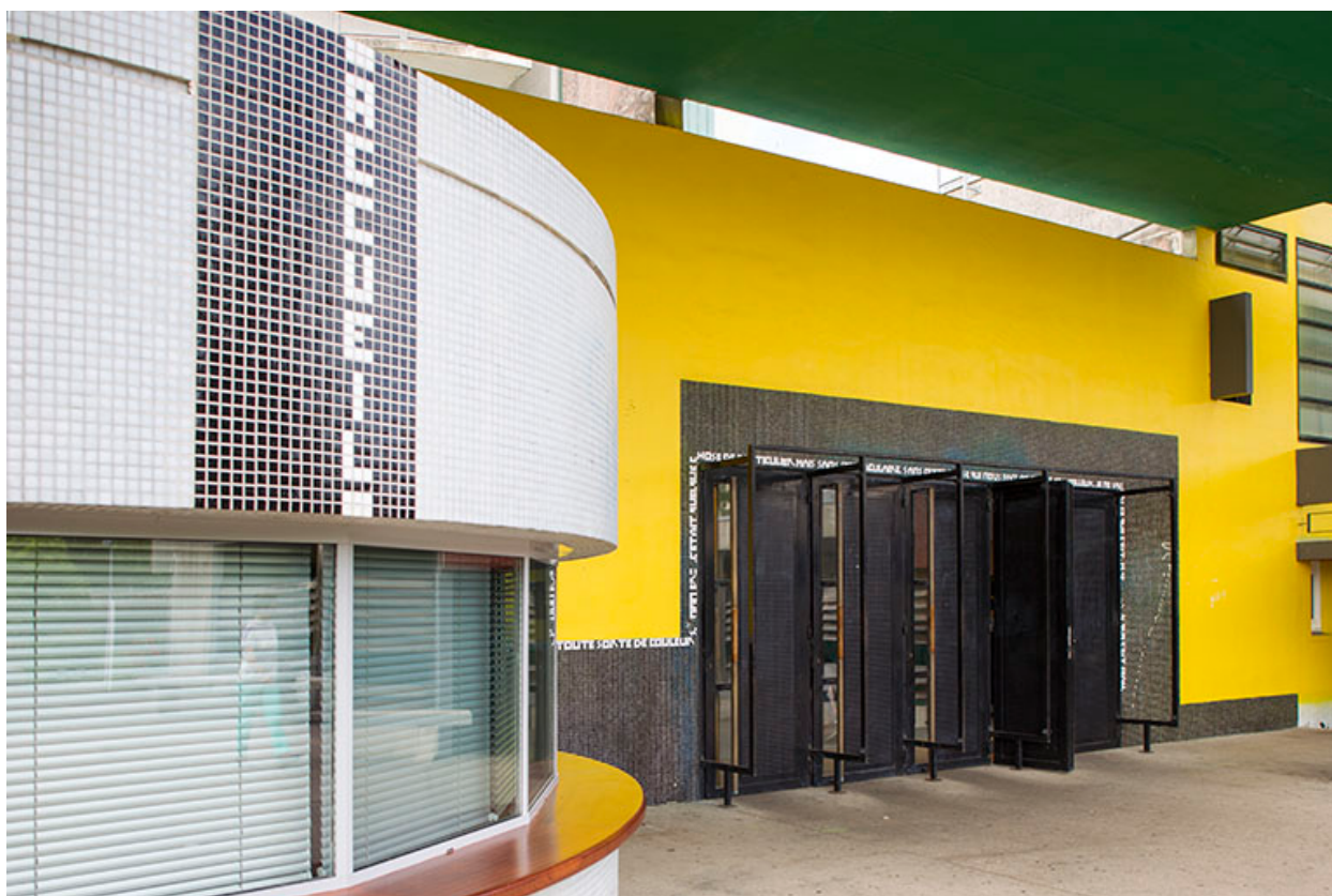
Détail de l'entrée vue de trois-quart sud.
