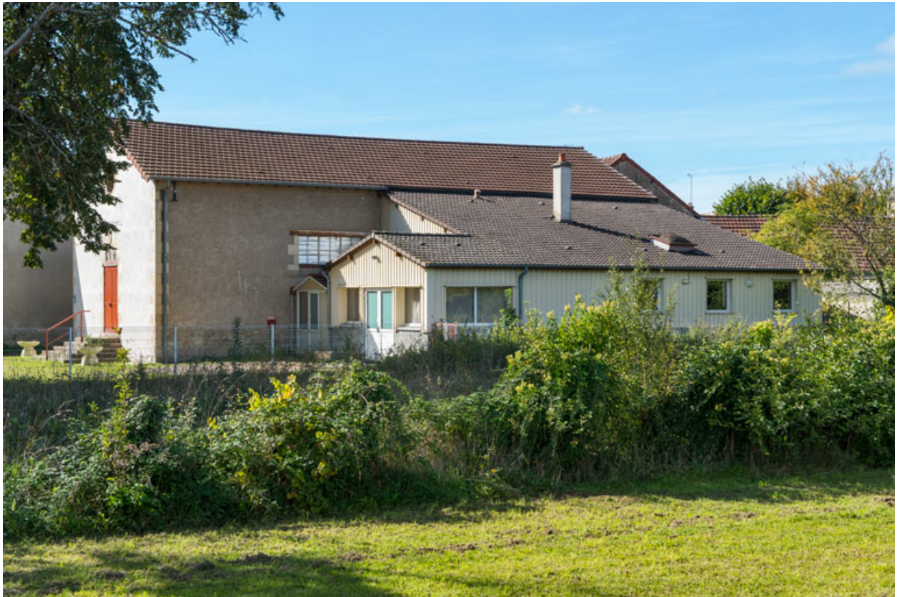
Façade latérale droite, de trois quarts gauche.
