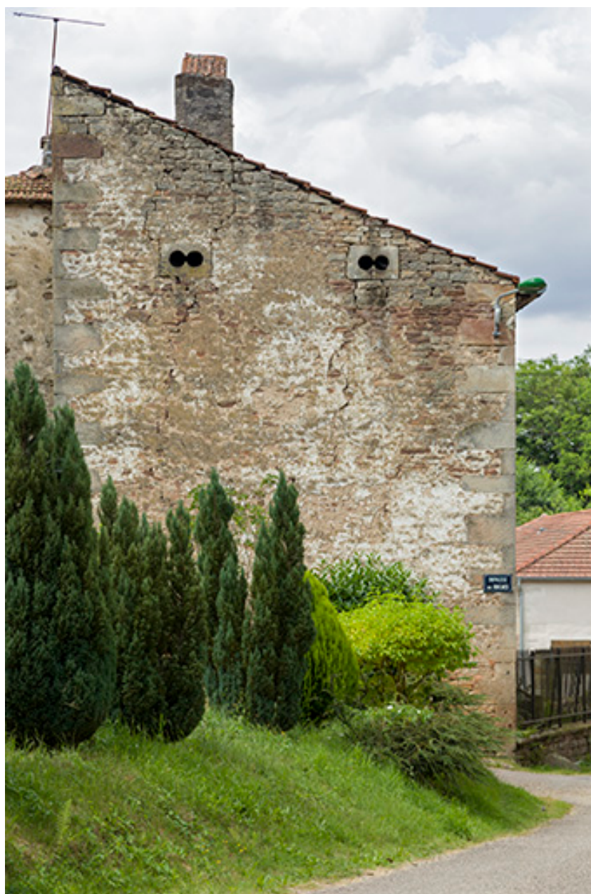
Mur pignon avec ses petits oculis.
