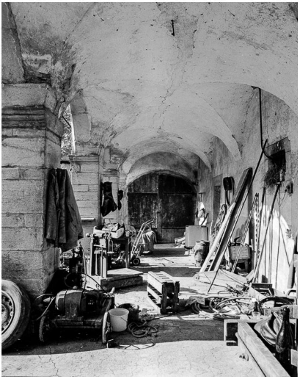
Corps de logis, rez-de-chaussée de la galerie.
