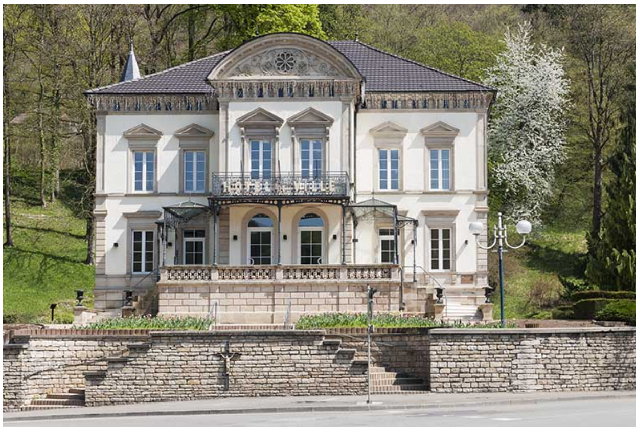
Façade antérieure vue de face.
