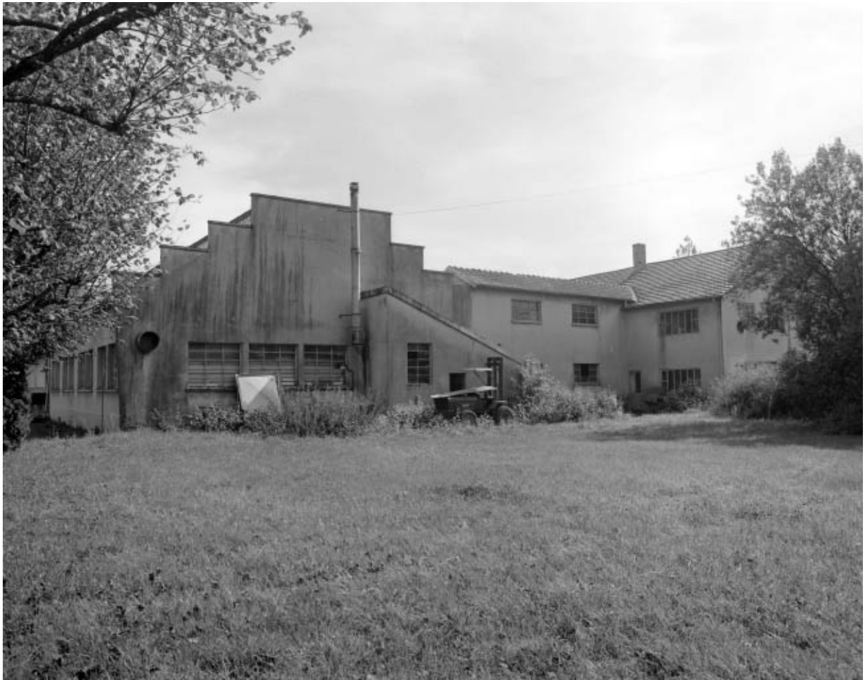
Façades postérieures des ateliers de fabrication.
