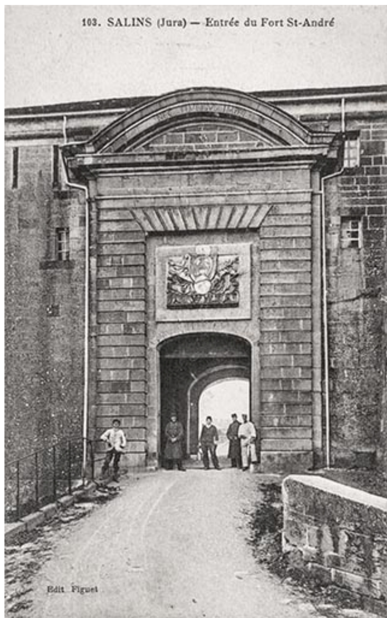
Salins-les-Bains (Jura). Entrée du fort Saint-André. S.d.
