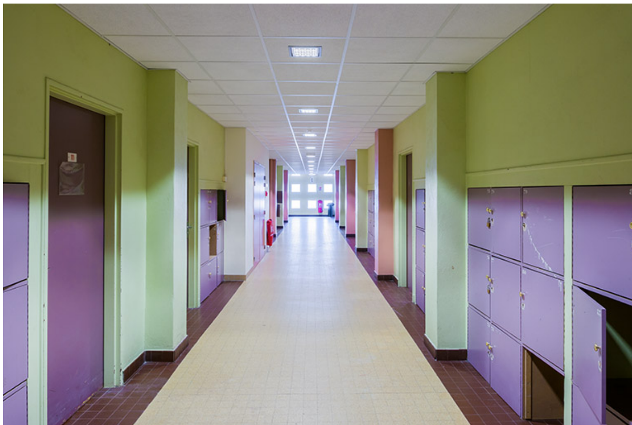
Couloir du premier étage l'externat.
