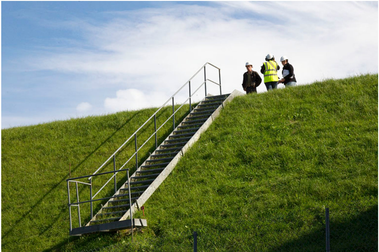
Digue : escalier menant à un puits piézométrique.
