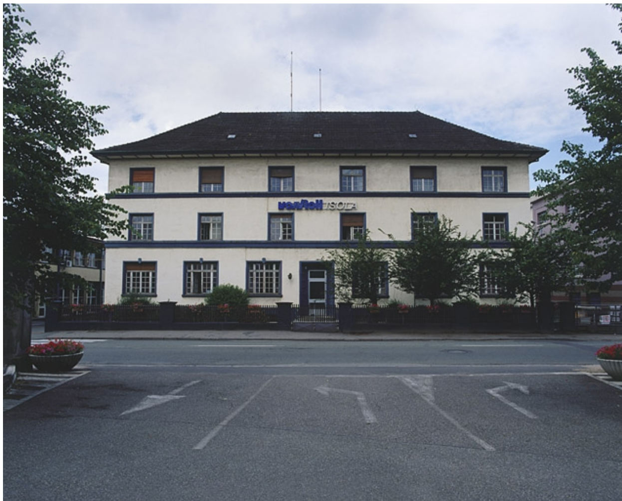
Bureaux (anciens logements).
