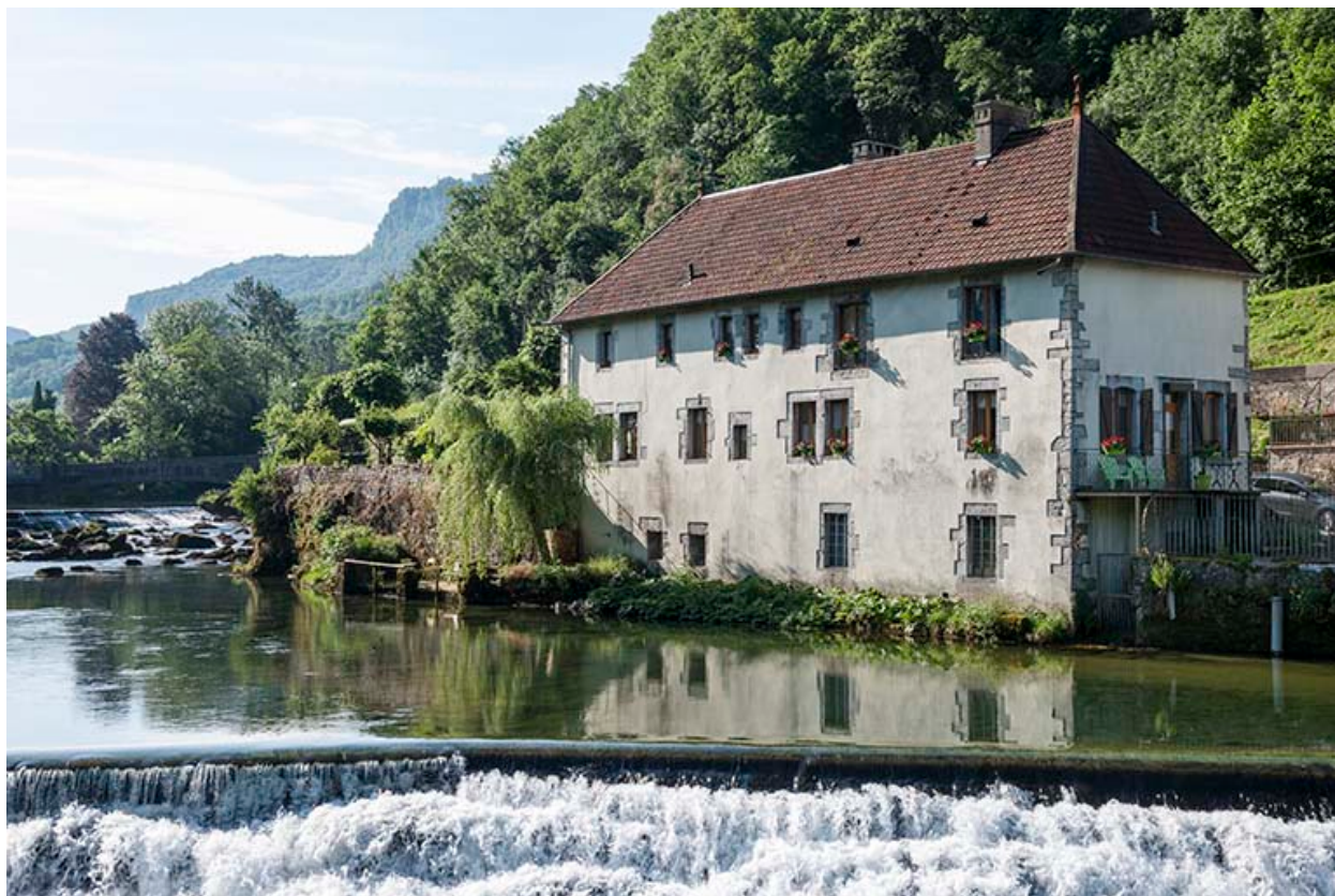
Logement d'ouvriers vu de trois quarts droite.
