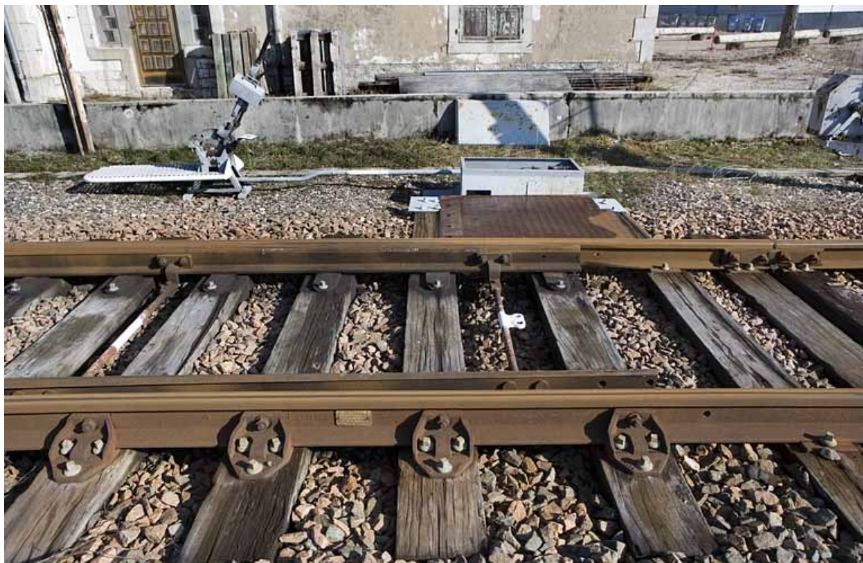
Levier de manoeuvre, système de renvoi d'angle et aiguilles.
