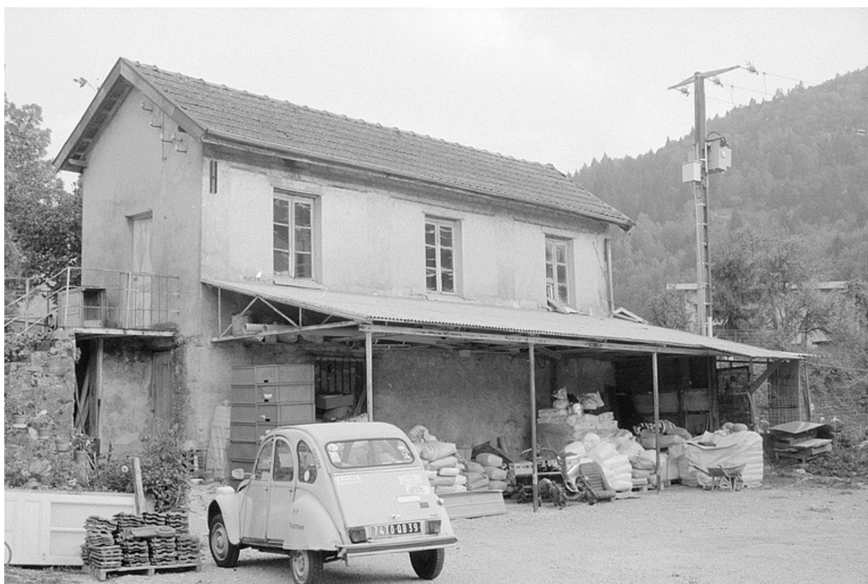
Ancien atelier de fabrication.
