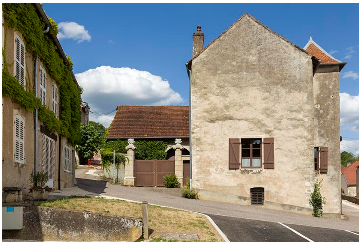
Vue générale depuis la place de l'Abondance.
