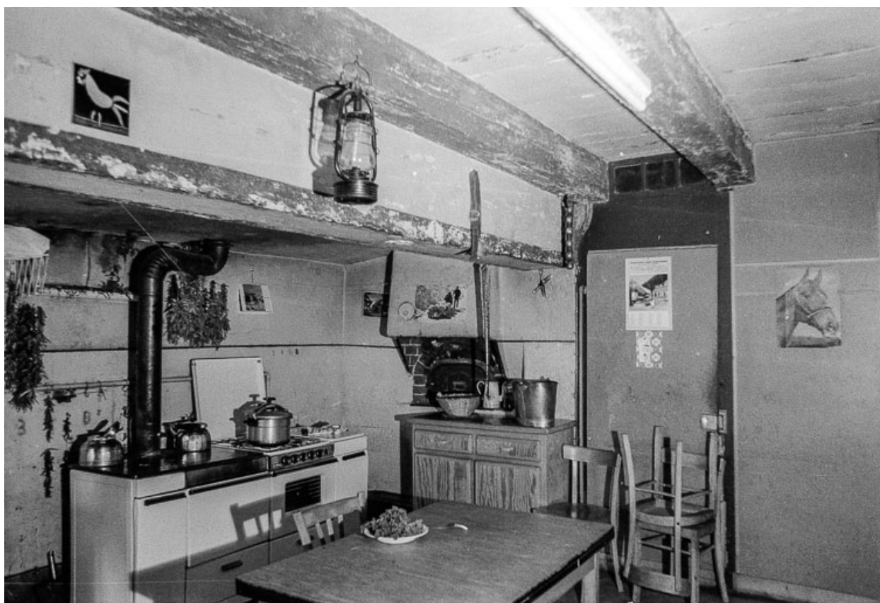
Cuisine : poutre supportant la cheminée.
