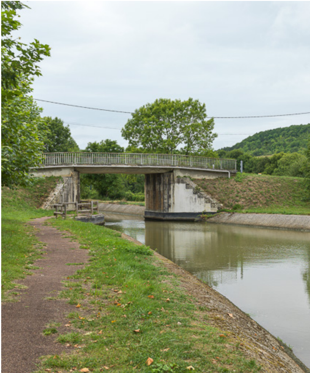
Vue d'ensemble du pont.
