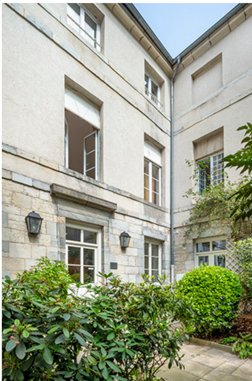
Aile sud vue depuis l'entrée.
