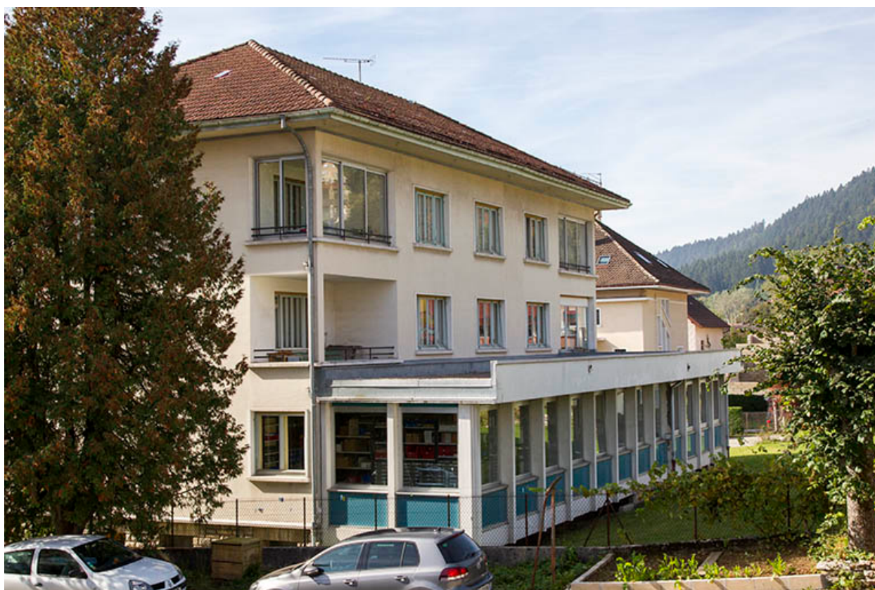
Façade postérieure, vue en enfilade.
