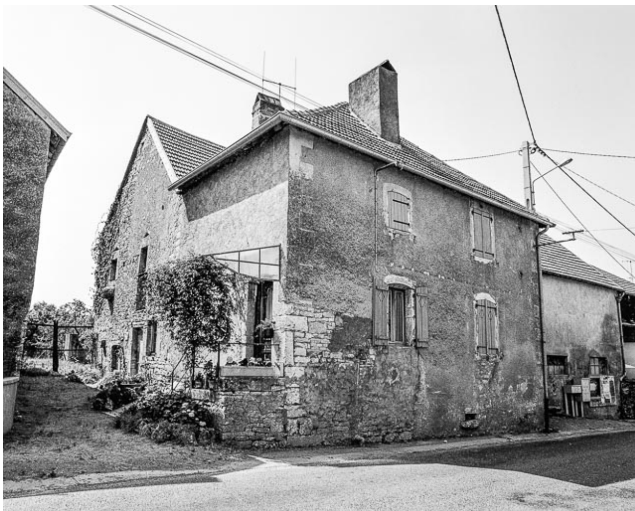
Maison située rue de Montbozon : façades antérieure et latérale droite sur la rue.
