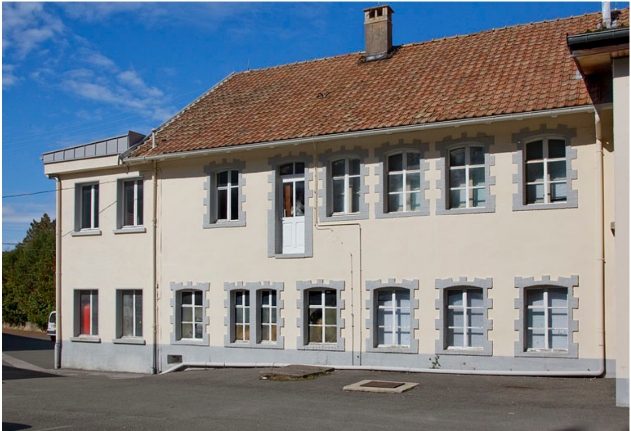
Atelier rehaussé en 1923-1924 : façade latérale droite.
