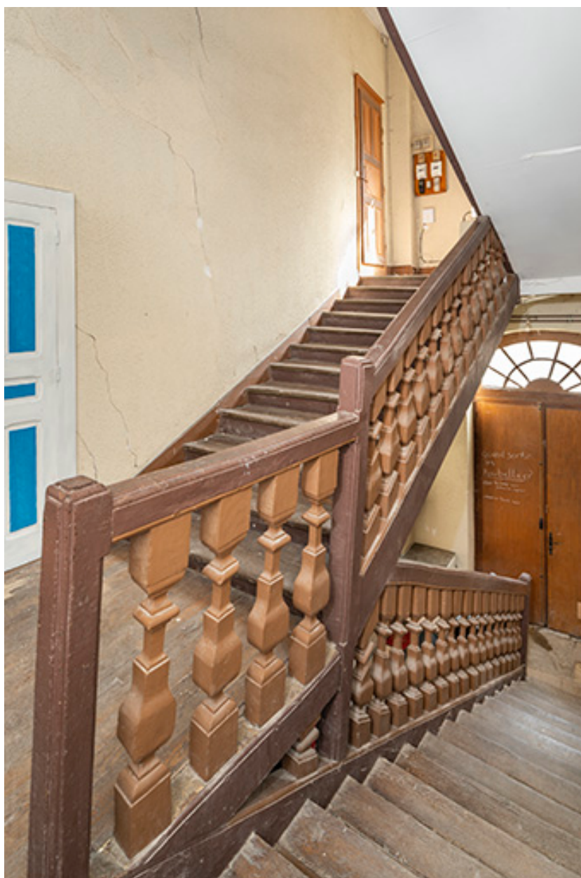
Escalier (n°3). Vue depuis l'entresol.
