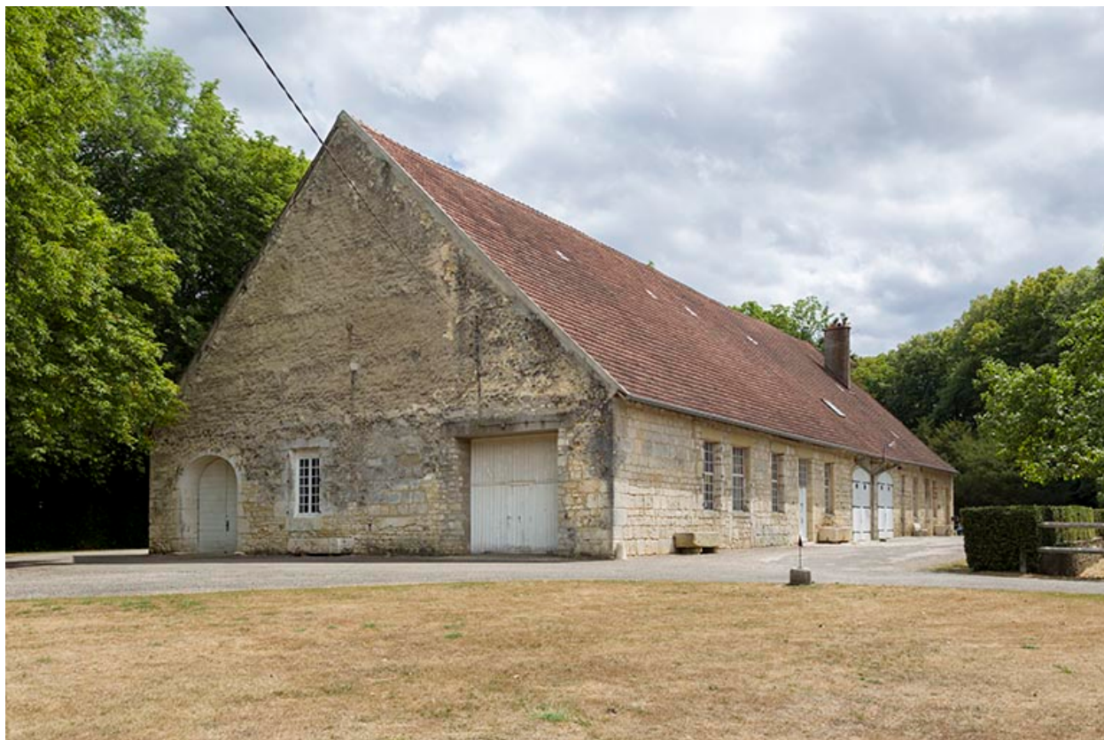
Vue de trois quarts de l'ancien manège.
