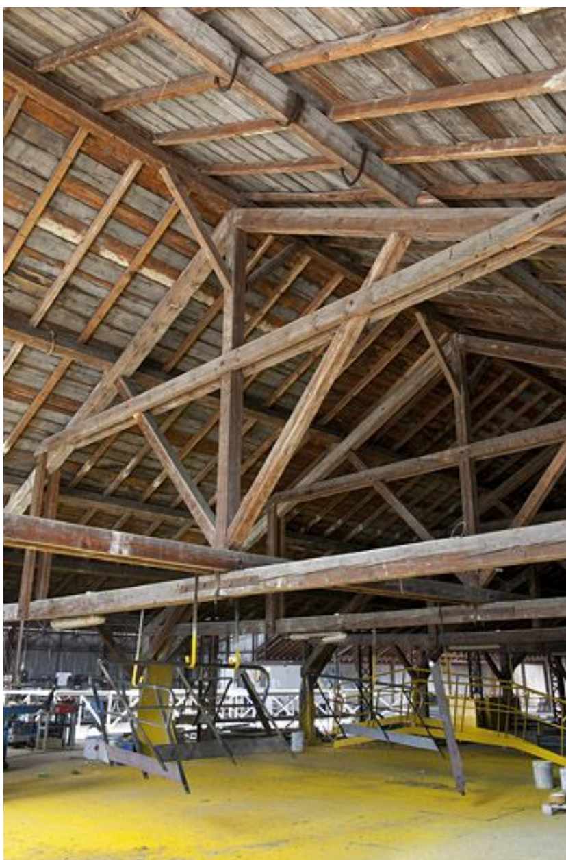
Entrepôt industriel. Charpente.
