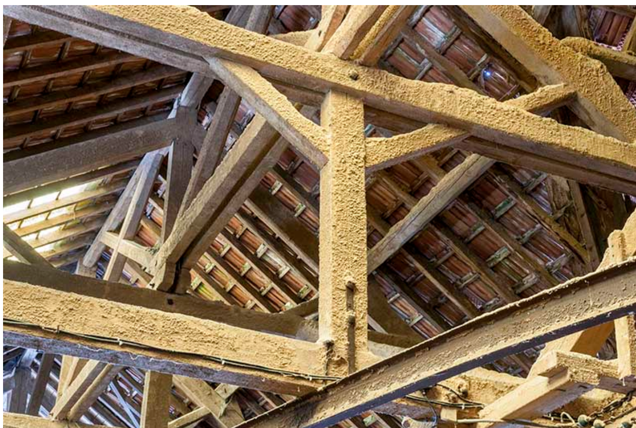
Détail de la charpente de l'atelier.
