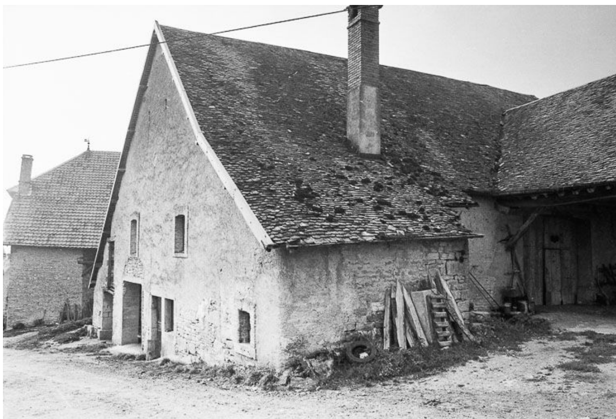
Ferme : vue de la partie habitation.
