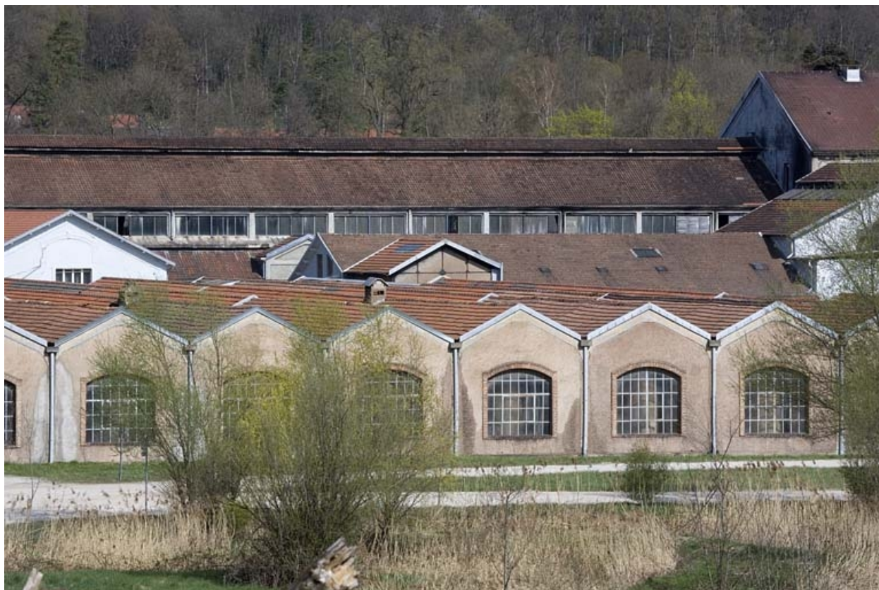
Pignons et toitures du magasin industriel depuis le sud.
