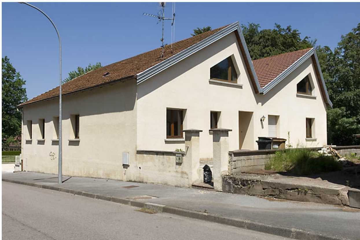
Ancien atelier de fabrication (polissage).
