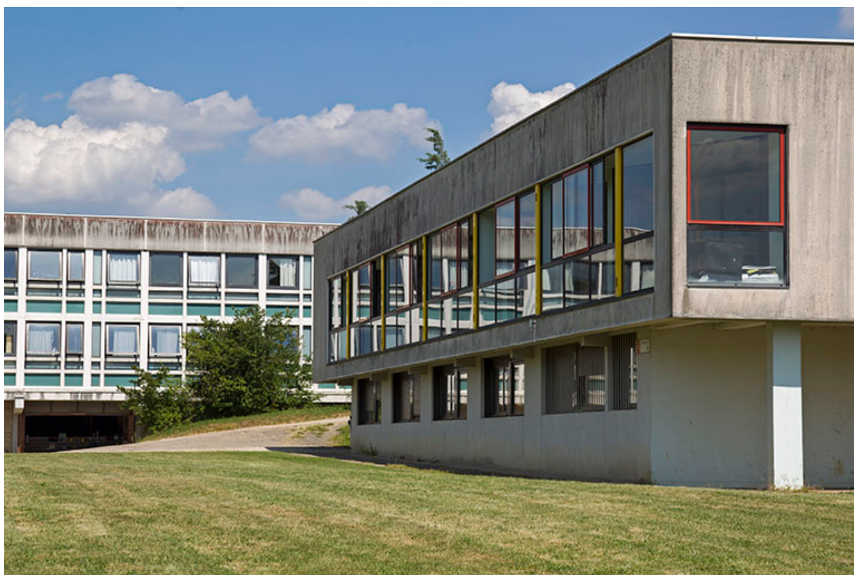
Angle nord-ouest du bâtiment d'internat de filles.
