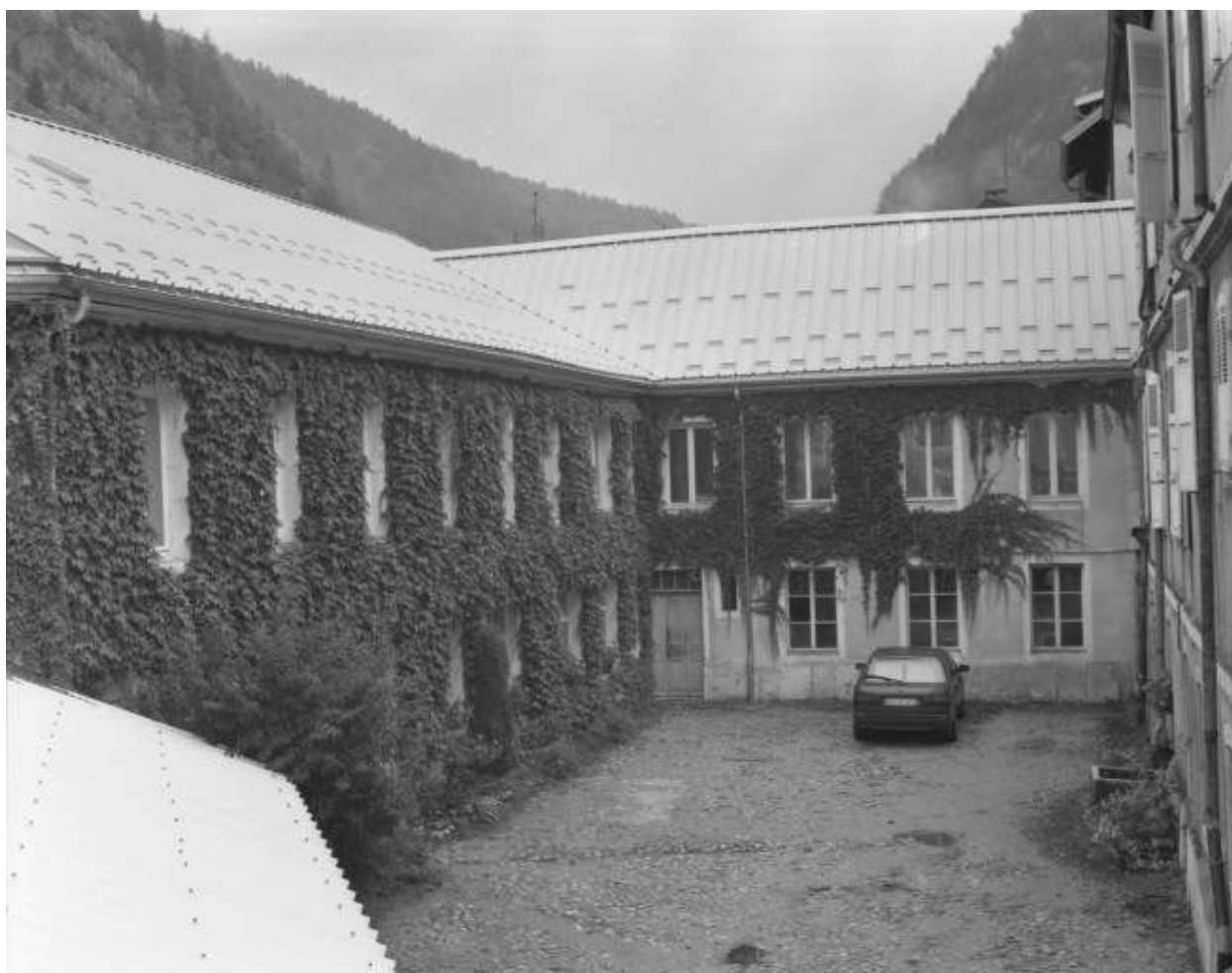
Façades de l'usine sur la cour.
