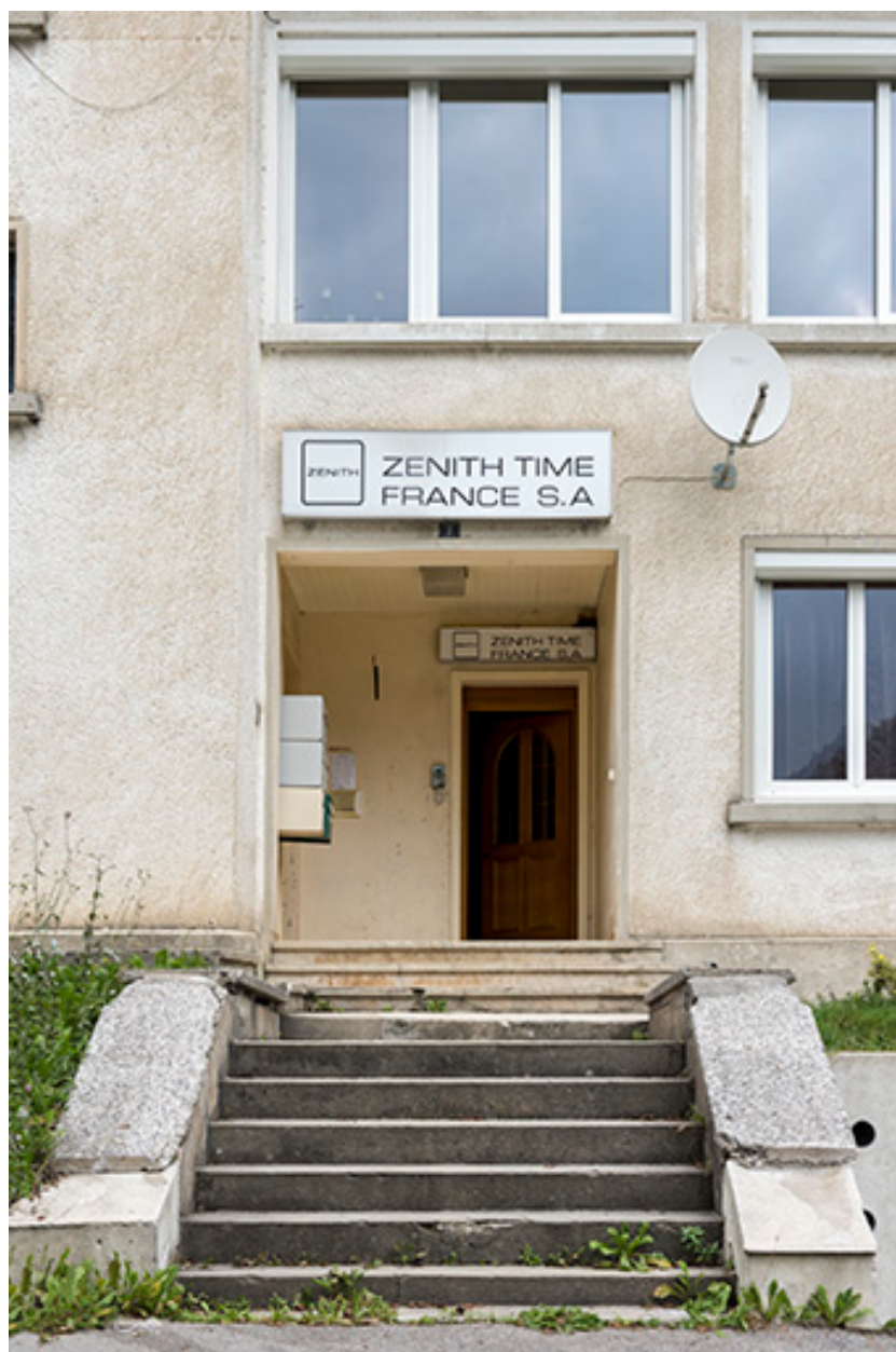
Façade antérieure : entrée de l'atelier de fabrication.
