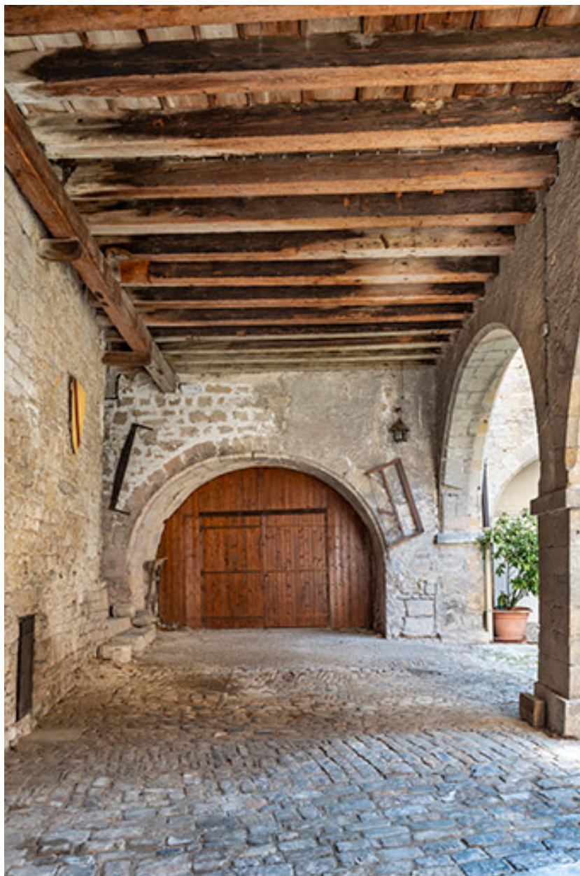
Aile nord. Passage couvert du rez-de-chaussée.
