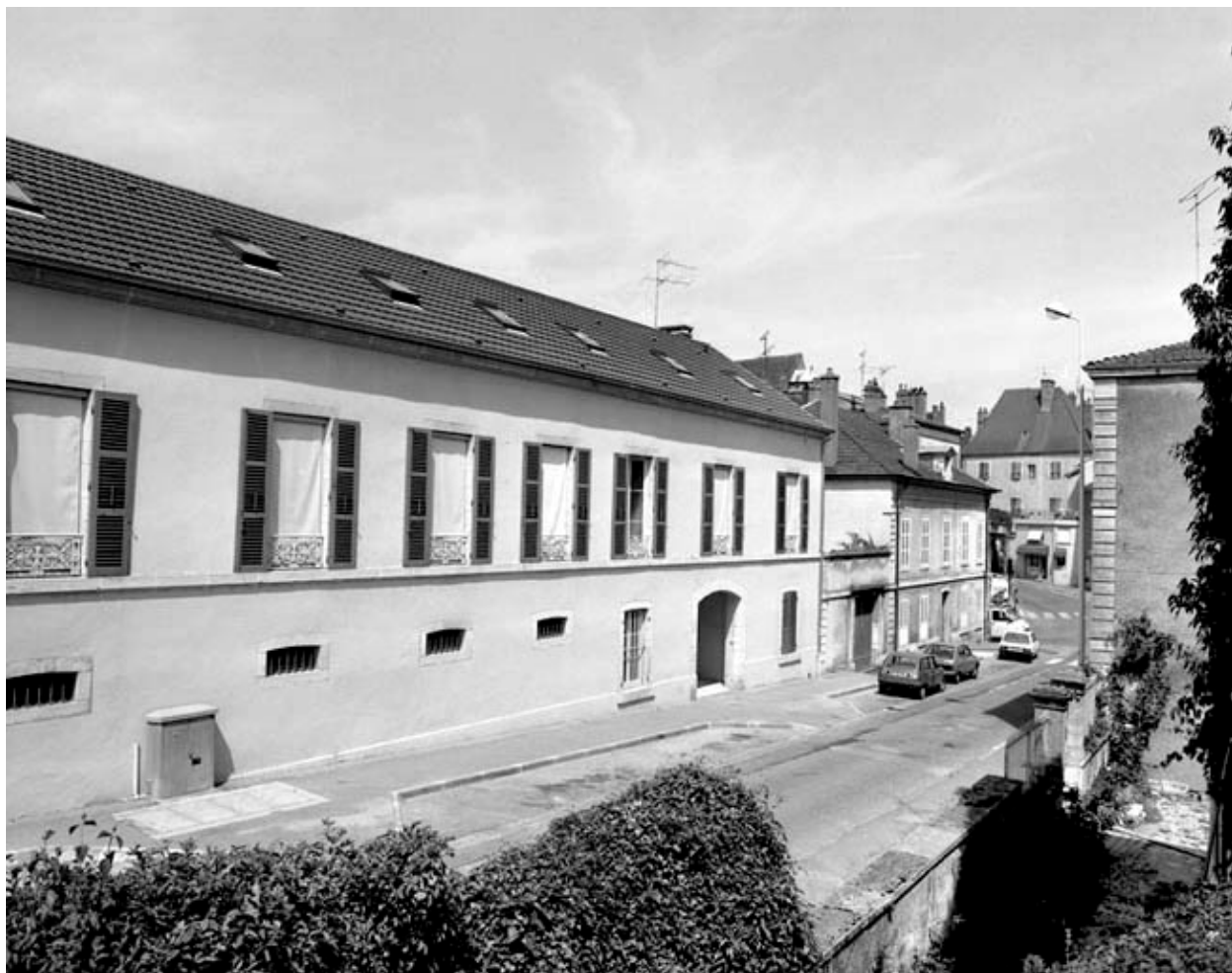
Façade antérieure de trois quarts gauche en 1989.
