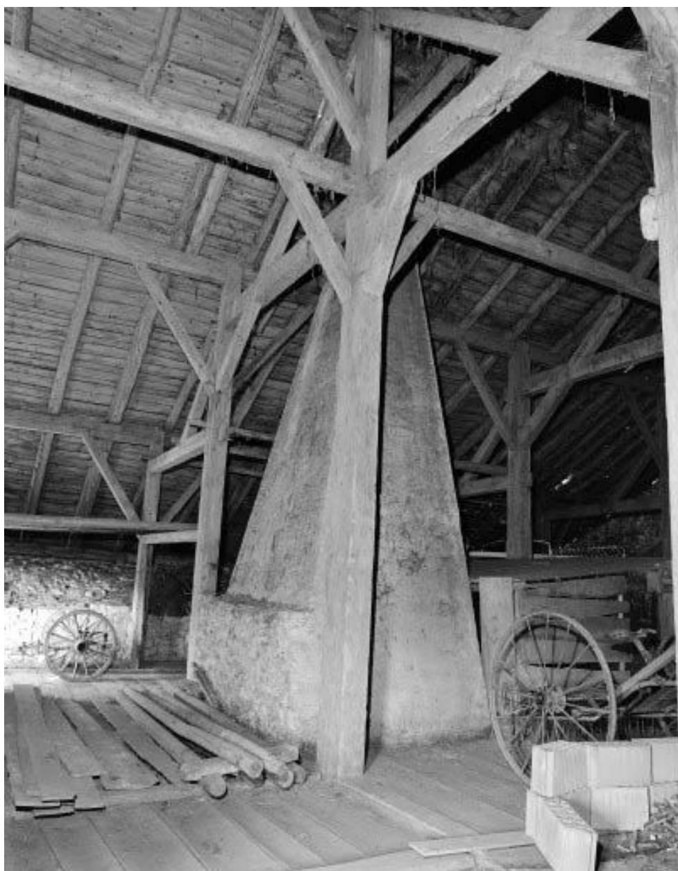
Charpente et conduit de cheminée.
