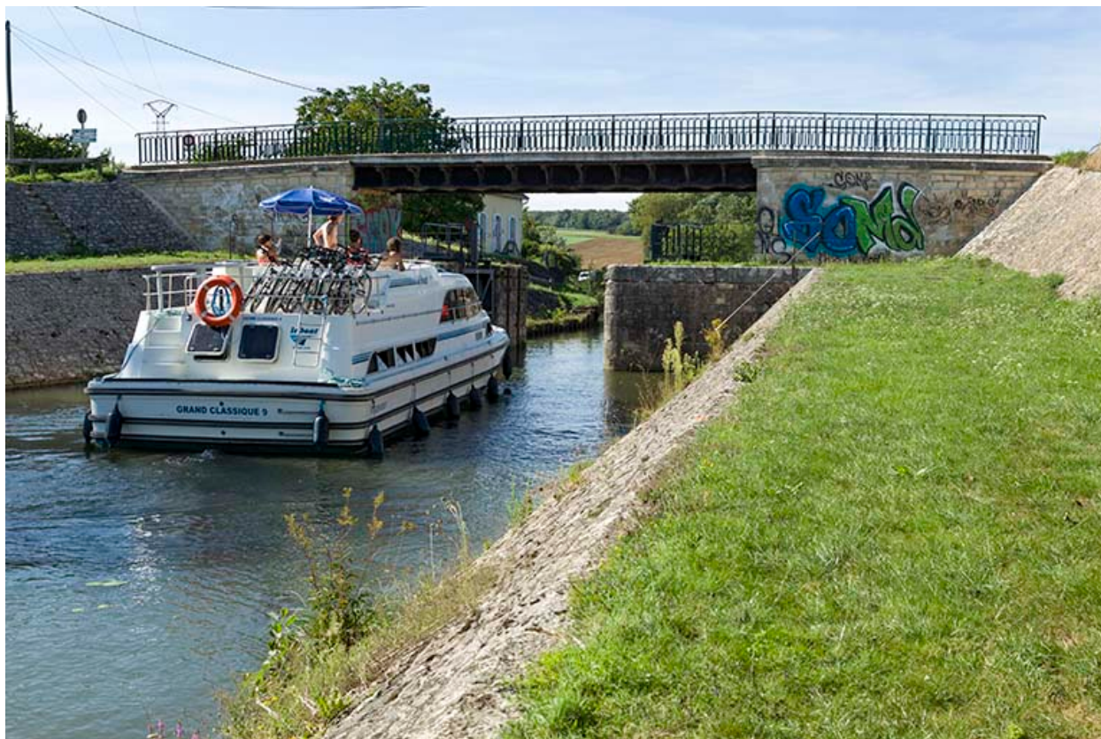
Bateau montant dans la porte de garde.
