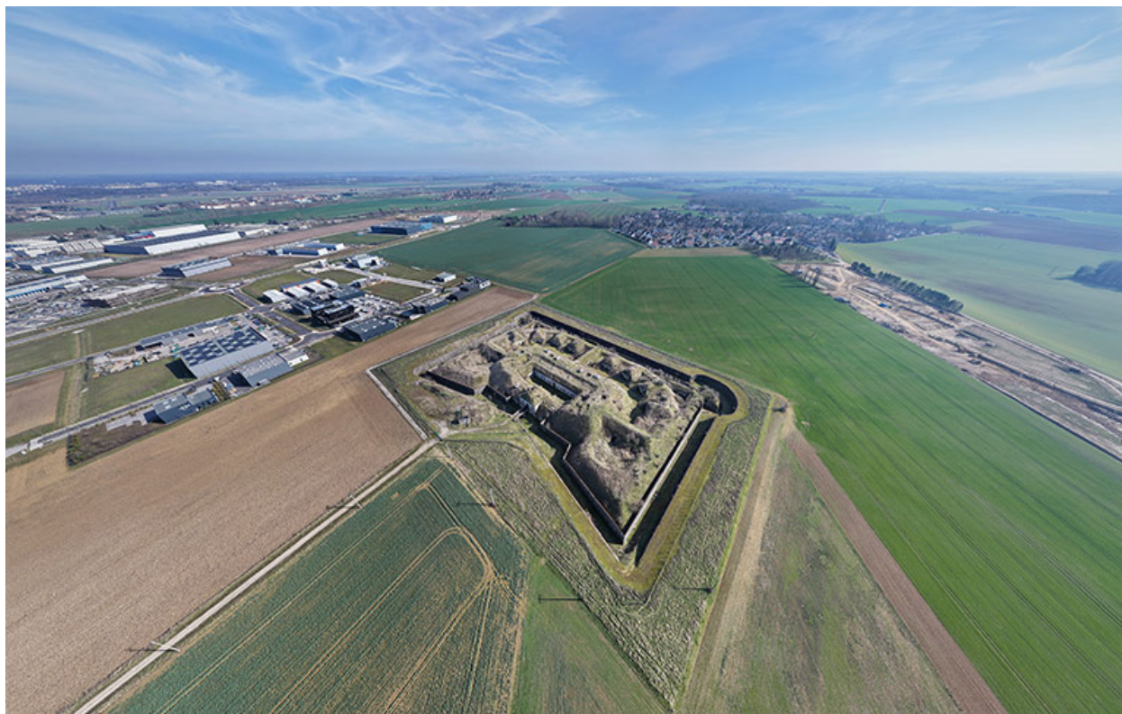
Vue aérienne de trois quarts droit. (vue aérienne).
