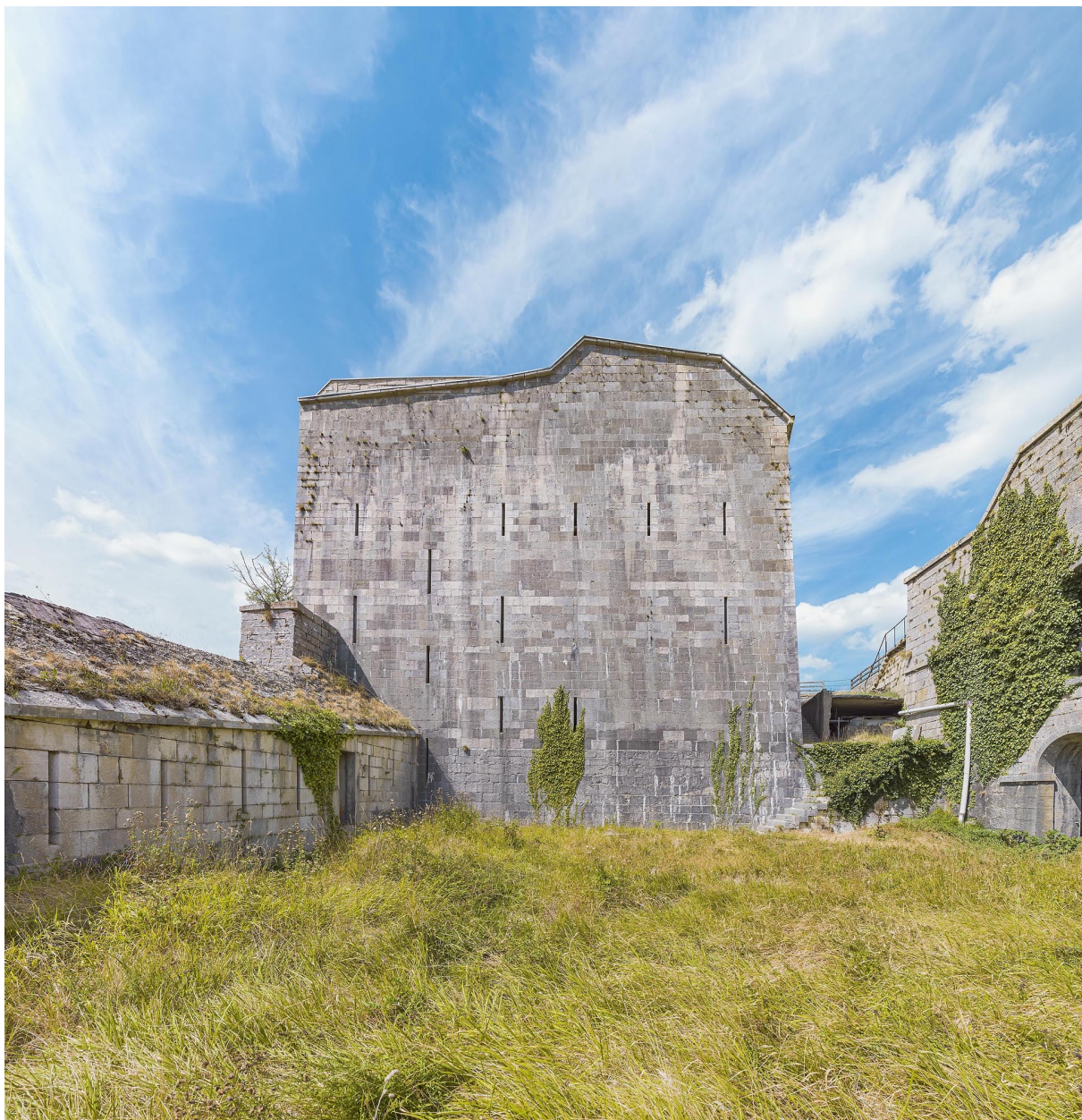
Mur pignon sud du réduit.
