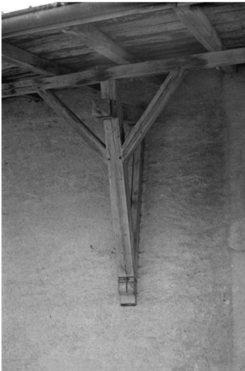
Ferme de 1818, située 11 Grande Rue : extrémité de la pièce de bois doublant le chevron-arbalétrier.
