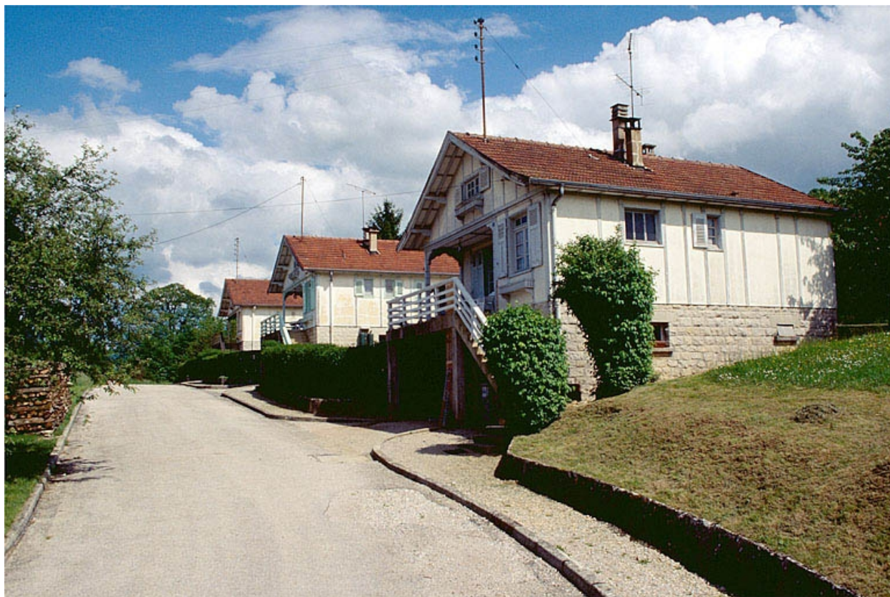
Logements d'ouvriers depuis l'ouest.
