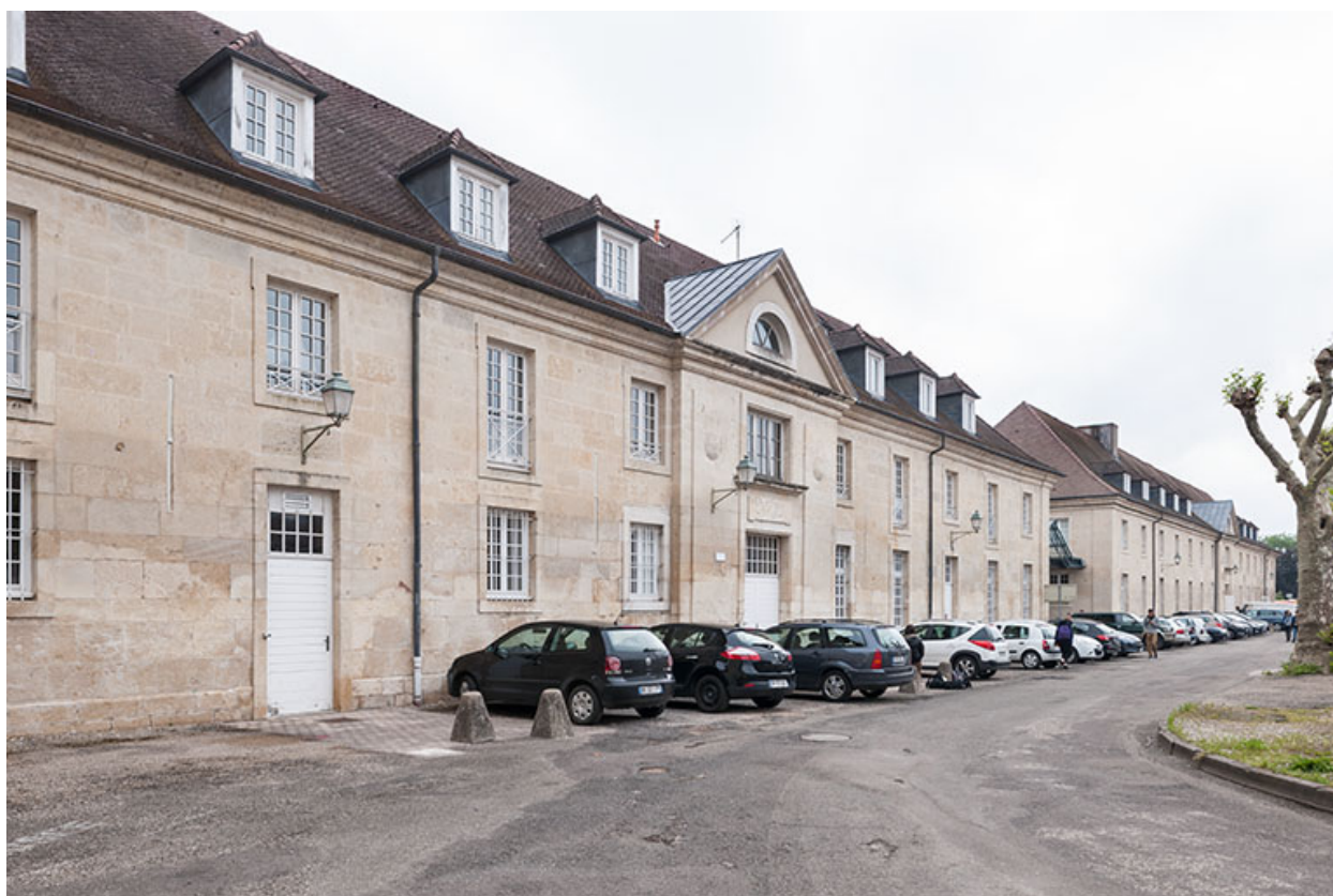
Bâtiment atelier-logement : façade postérieure, vue 3/4.
